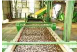
Siebmaschine in der Trocknungsanlage
